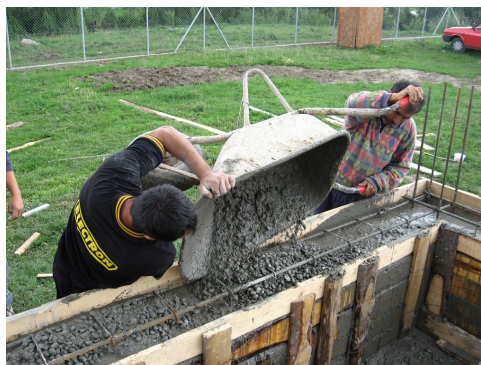
Lábazat betonozása
